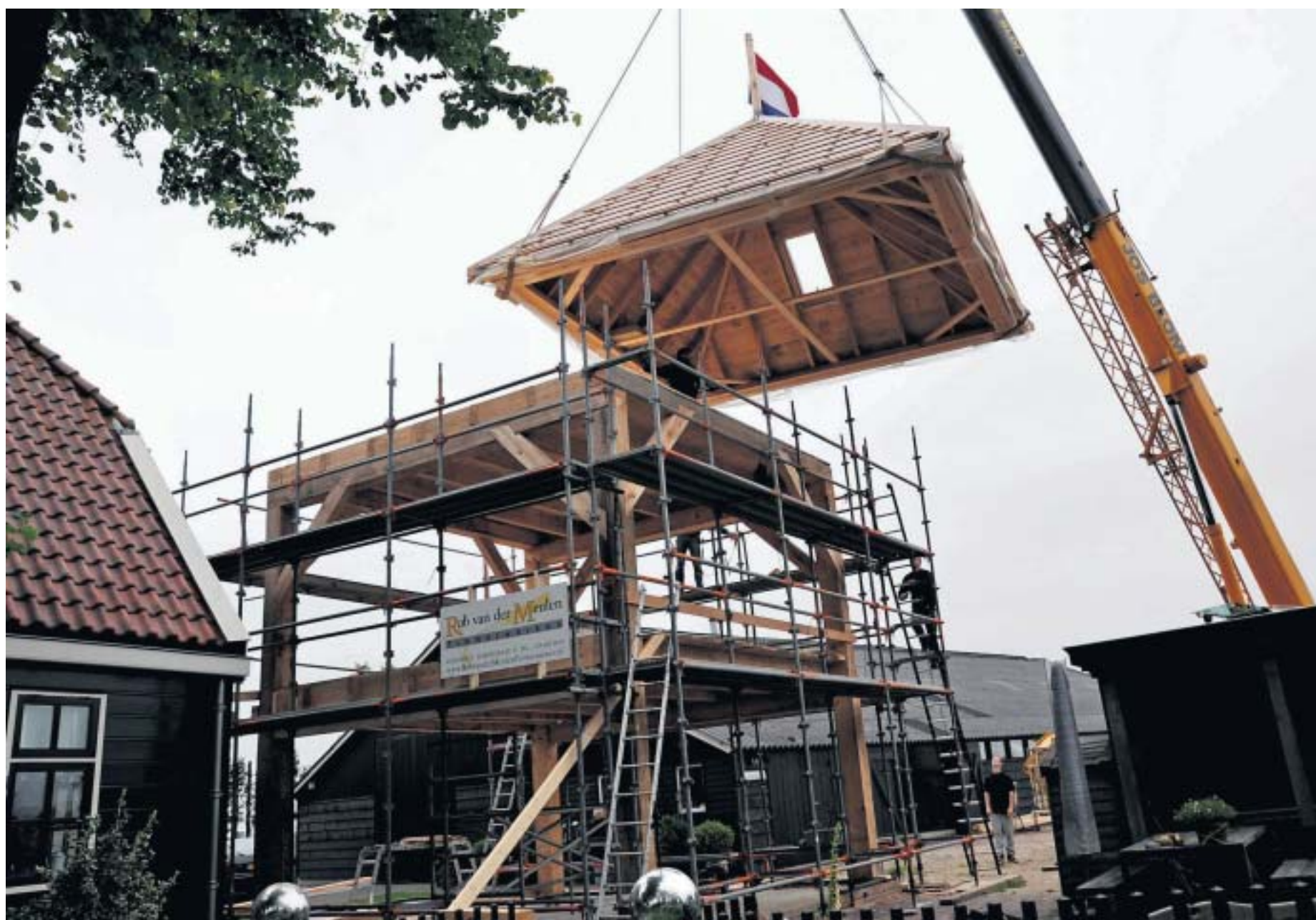
Hijzen van de kap op het vierkant bij Timmerbedrijf Rob van der Meulen.
